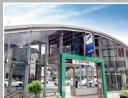
地下鉄七隈線「六本松」駅
